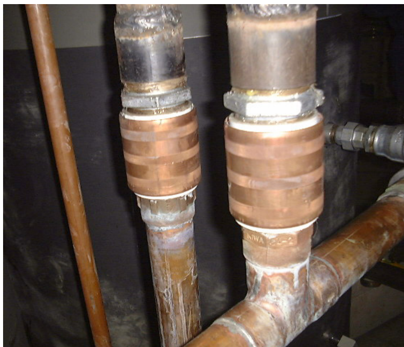
Figura 3.45 Fotografía de manguitos dieléctricos
