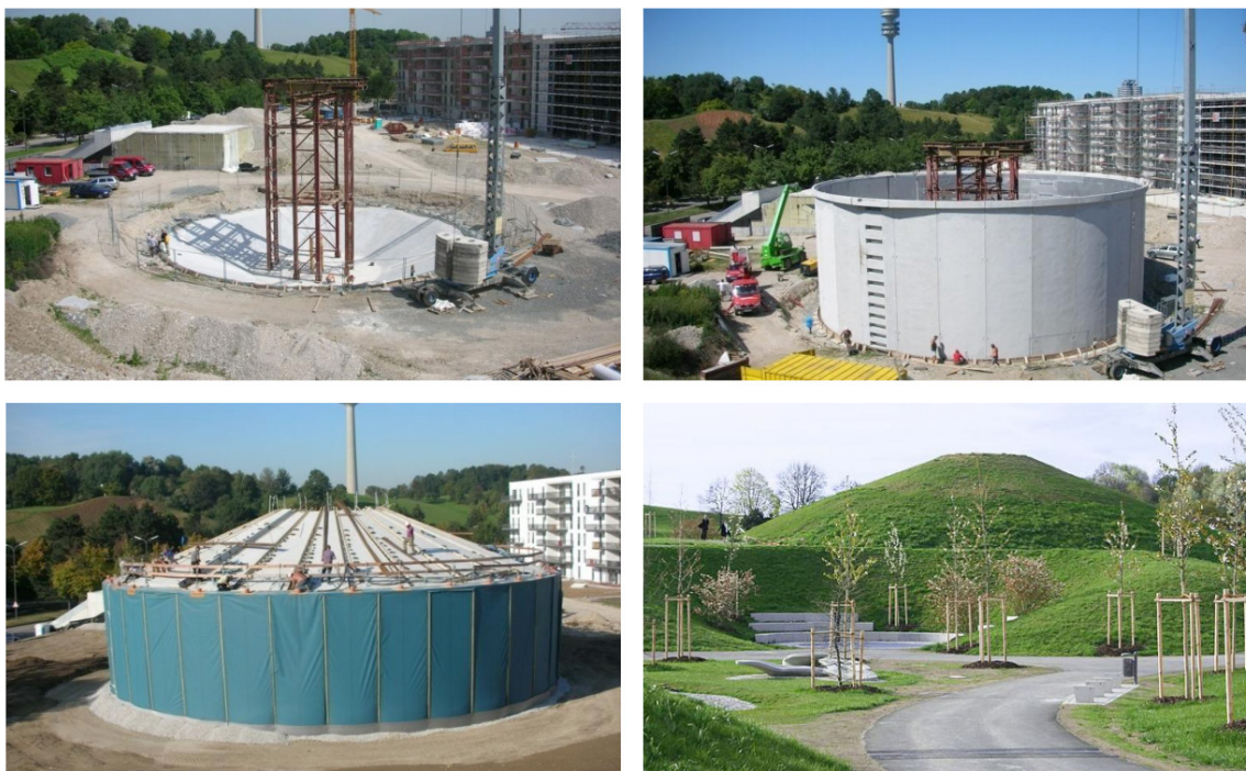
Figura 4.20 Acumulador estacional tipo TTES de 5700 m3 en Múnich. Fuente SOLITES
