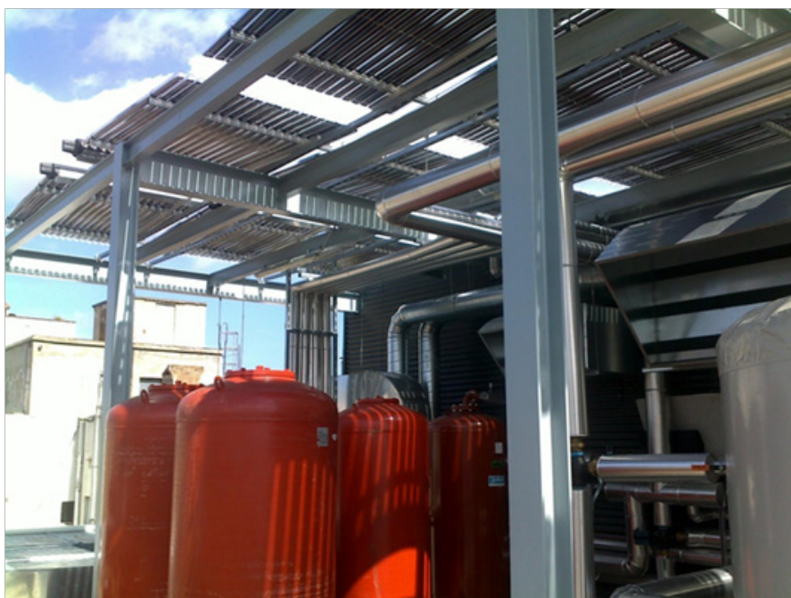
Figura 3.17 Colector de tubo de vacío. Fuente: AIGUASOL
