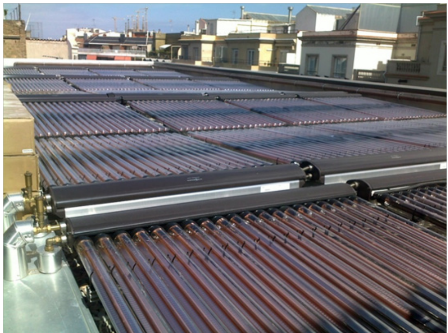
Figura 3.15 Instalación de tubos de vacíos para la industria
