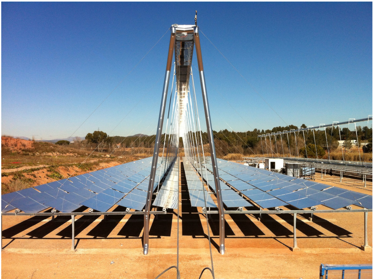
Figura 3.21. Linear Fresnel Collector por cortesía de AIRA TERMOSOLAR
